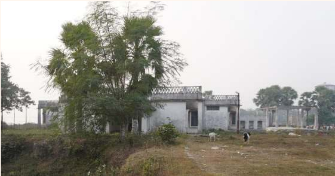
(8) स्थल पर निर्मित भवन
